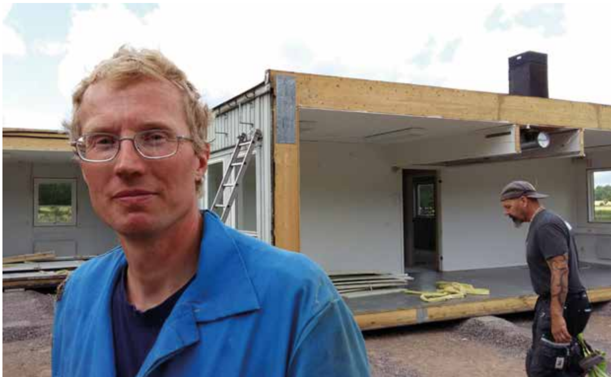
Just nu pågår arbetena med att färdigställa Östra Ryds nya livsmedelsaffär. Här ser du byalagets ordförande Ulrik Nilsson i arbete.
