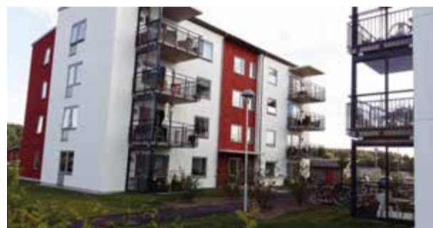
Första etappen av byggnationen på Vikingavallen är nu klar.
